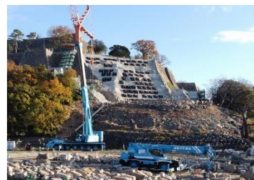
【現在の復旧工事の様子】
