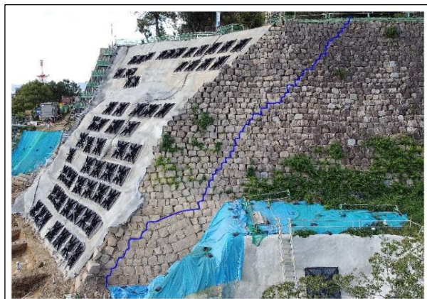
【承認された追加解体範囲（青のライン）】
