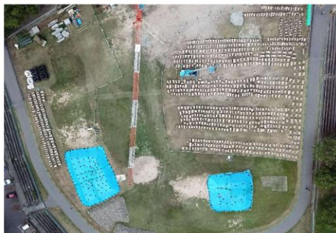
城内グラウンド 石材仮置き状況
