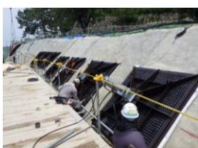
アンカー緊張 確認作業の様子
