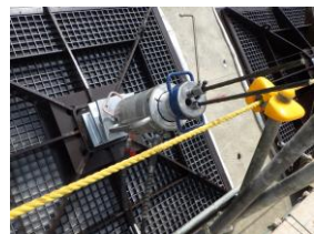
アンカー緊張 確認作業の様子
