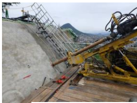
グラウンドアンカー打設のため削孔中のボーリングマシーン 【6月9日撮影】
